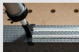
Tipp: Die Verwendung einer Akkukartuschenpistole sorgt für eine besonders gleichmäßige Dosierung und erleichtert die Handhabung.
