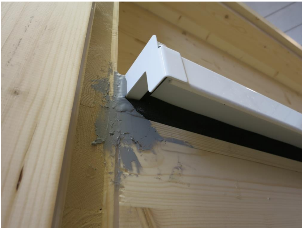
Bild 8 Ausbildung der Anschlussfugen mit vorkomprimiertem Dichtungsband und Dichtstoff
