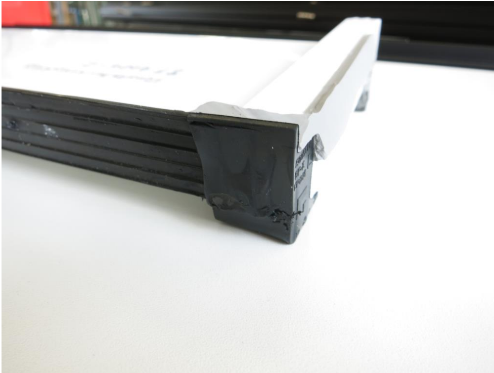
Bild 9 Fensterbankabschluss BF 4006-Z mit Fensterbankdichtung UD400-1
